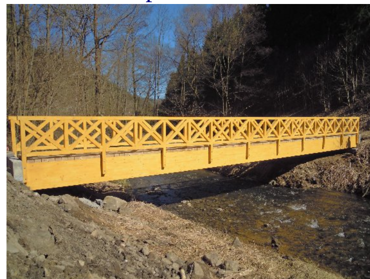
Foto: Petra Zbořilová, montáž lávky č. 4
