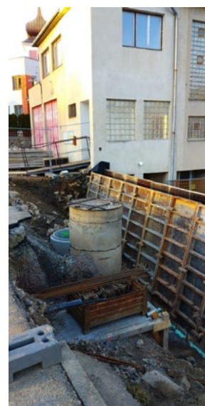
Oprava opěrné zdi na hrázi rybníka Foto: Petr Konečný 2x
