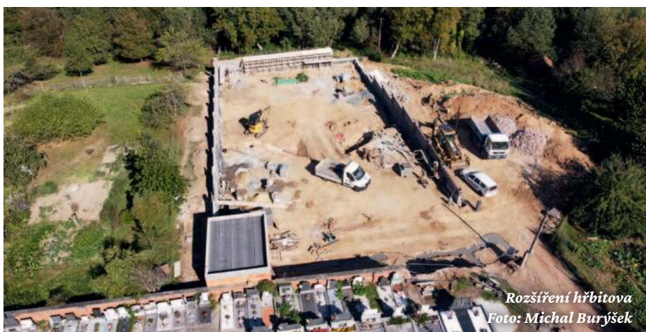
Rekonstrukce domu čp. 32 Foto: Petr Konečný
